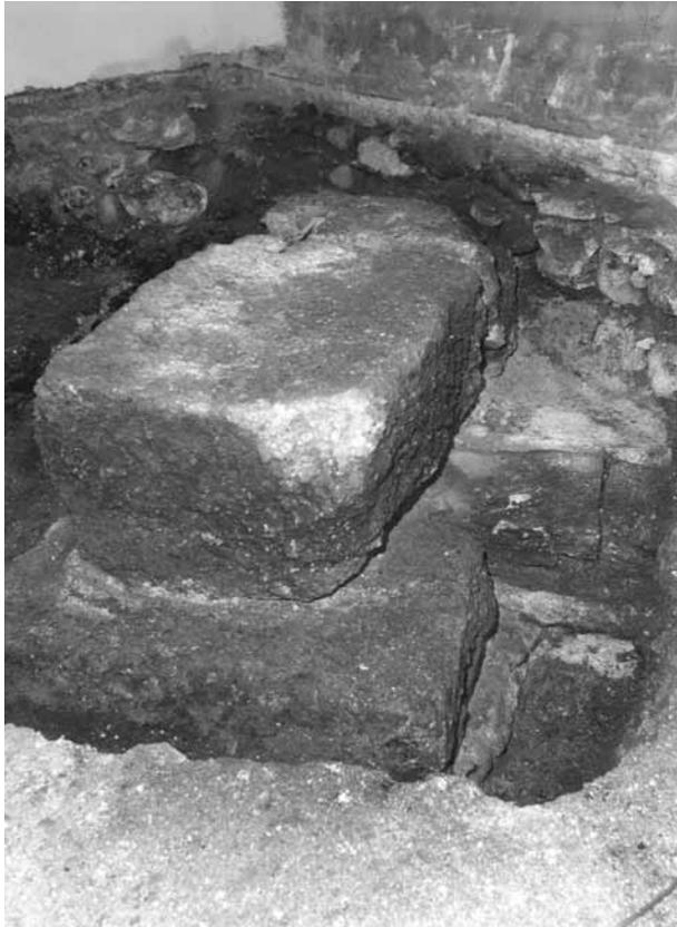
Abb. 12 Geklammerte Nagelfluhquader auf massivem, abgewinkelten Fundament in der Nordwestecke des Kircheninnenraumes. Quaderbreite: 0,90m
