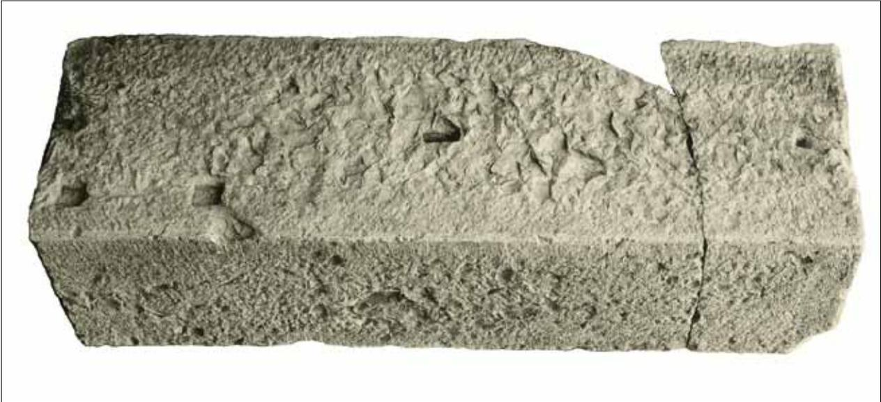
Abb. 14 Bauquader aus Untersberger Marmor mit zentralem Hebeloch, Klammerlöchern an den Schmalseiten, links mit erhaltenem Eisendorn, und weiteren Einarbeitungen. Gefunden 1957 vor der Nordseite des Kirchenschiffs. L. 1,96m
